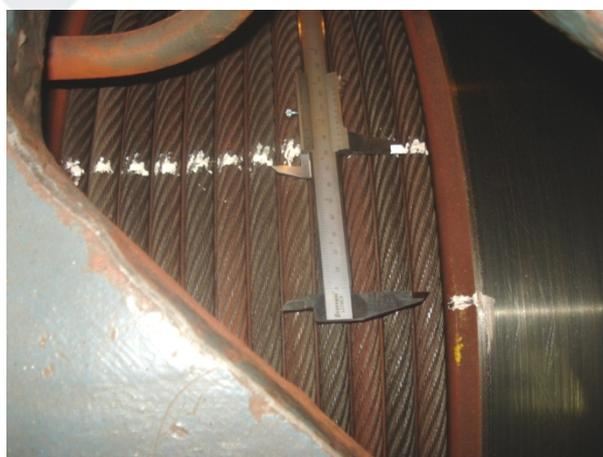
Neste exemplo constatamos que a polia apresenta desgaste inicial, não necessita de substituição preventiva, pois o deslizamento em duas viagens foi de 12cm.
